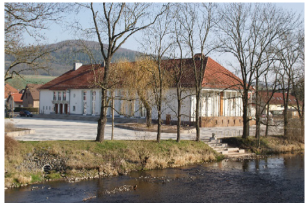
Saniertes Kulturhaus an der Ulster
