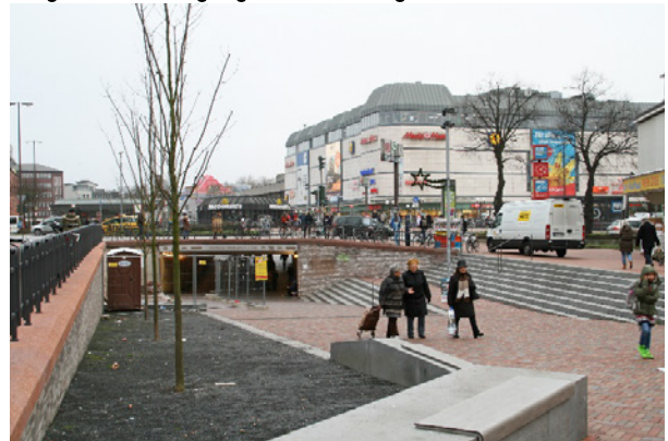
Umgestaltete Fußgängerunterführung zum Bahnhof Altona
