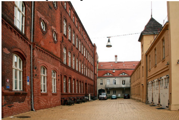
Stadtverwaltung in ehemaliger Fabrik
