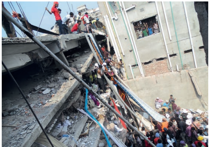
Eingestürztes Rana Plaza-Gebäude 2013, Foto: Bangladesh Center for Workers Solidarity and the Solidarity Center
