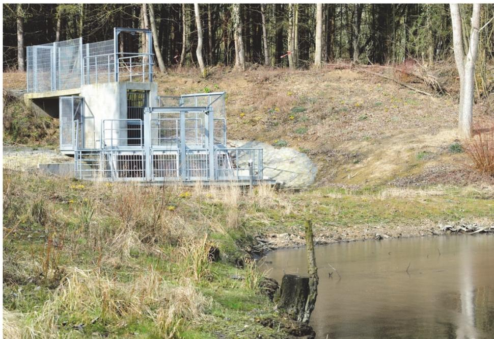
Bild 9: Auslaufbauwerk am südwestlichen Ende des Kraftwerksteiches
