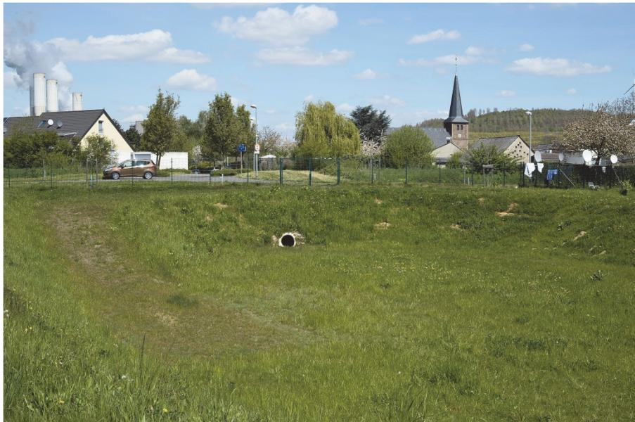
Bild 20: Regenrückhaltebecken im Nebenschluss zum Graben Am Glockenstrauch
