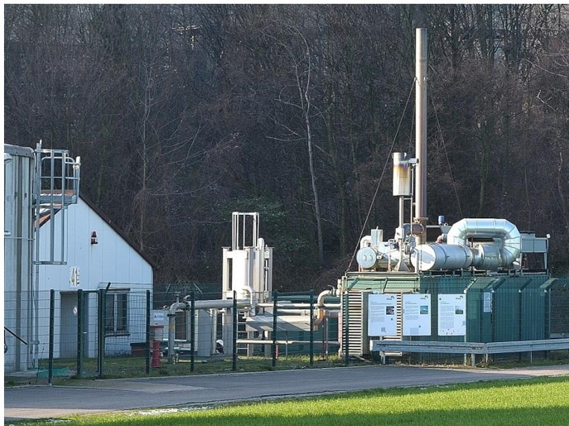
Bild 23: Blockheizkraftwerk in Neurath, in dem aus dem hergestellten Biogas Strom und Wärme erzeugt werden.
