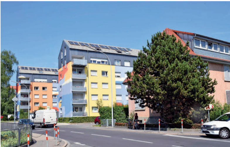
Sanierte Wohnhäuser Konstanz-Berchen
