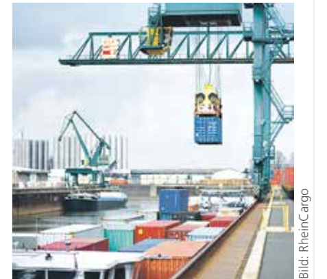
Das Container Terminal in Köln Niehl aus Sicht eines Kranführers
