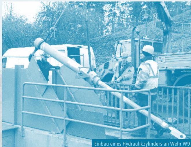
Einbau eines Hydraulikzylinders an Wehr W9
