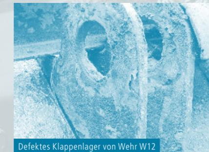
Defektes Klappenlager von Wehr W12
