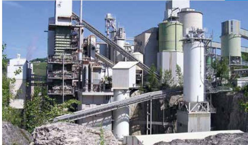
Drehrohröfen können mit Wärmeaustauschern ausgestattet werden. Die aus dem Verbrennungsgas zurückgewonnene Wärme kann dann dazu verwendet werden, den aufgegebenen Kalkstein vorzuwärmen. Schachtöfen sind bereits mit einer Vorwärmzone ausgestattet.
