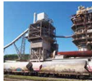
Verkürzung eines Drehrohrofens bei Einbau eines Vorwärmers
