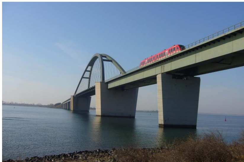
Abbildung 1: Ansicht Fehmarnsundbrücke von Nordost [eigenes Foto März 2015]
