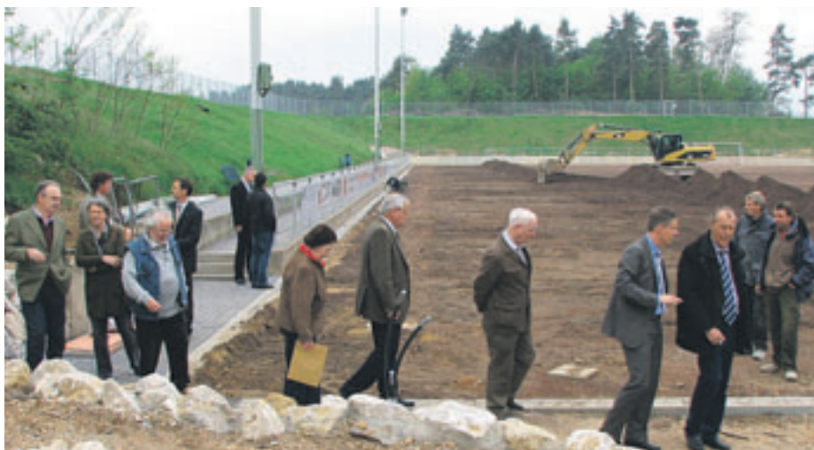
Bürgermeister Peter Schlösser sowie Vertreter aus Politik und Verwaltung nahmen die Baumaßnahmen am Sportplatz Lommersum in Augenschein. -ff-
