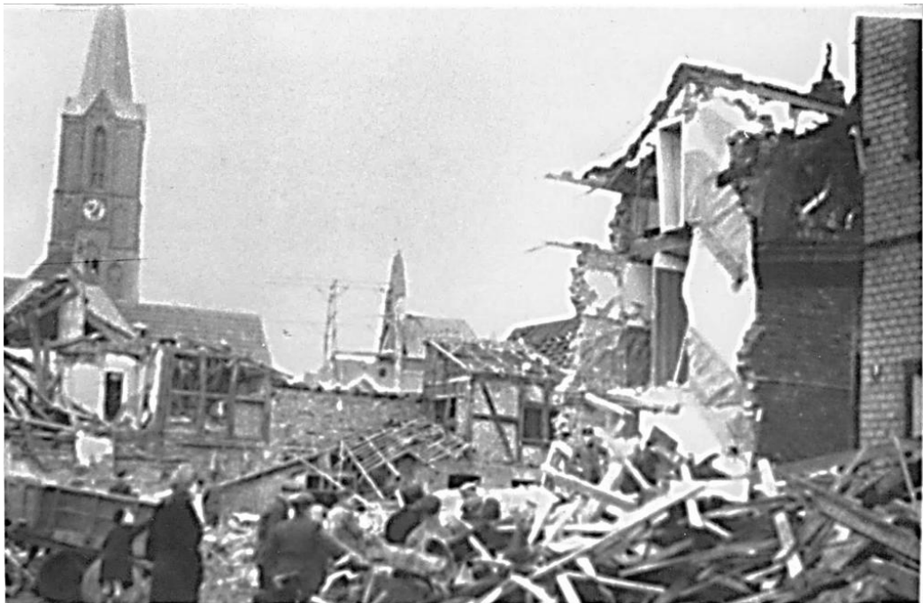
(aus der Sammlung Krein) 1944 / 1945 – durch Bomben zerstörte Häuser (u. a. Metzgerei Häring) Ecke Hauptstraße / Bahnhofstraße
