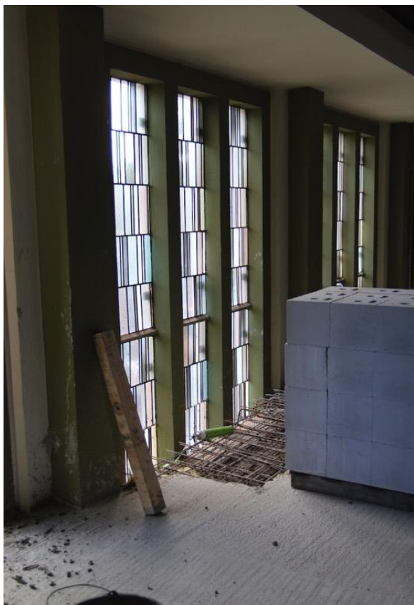
Abbildung 3: Zwischendecken werden eingezogen
