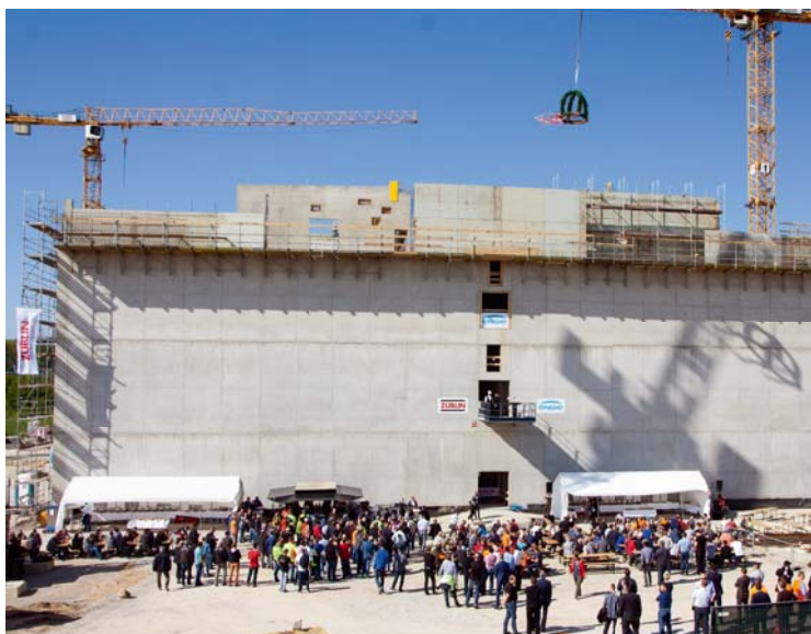
Mit dem Richtfest ist ein wichtiger Meilenstein bei der Erweiterung des Dynamic Data Centers erreicht.
