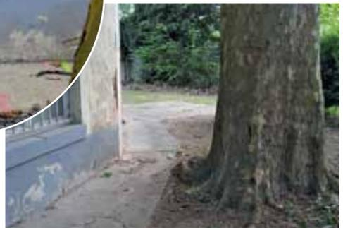
Der Druck der Platanenwurzeln erzeugte diesen Riss im Mauerwerk des Wintergartens.
