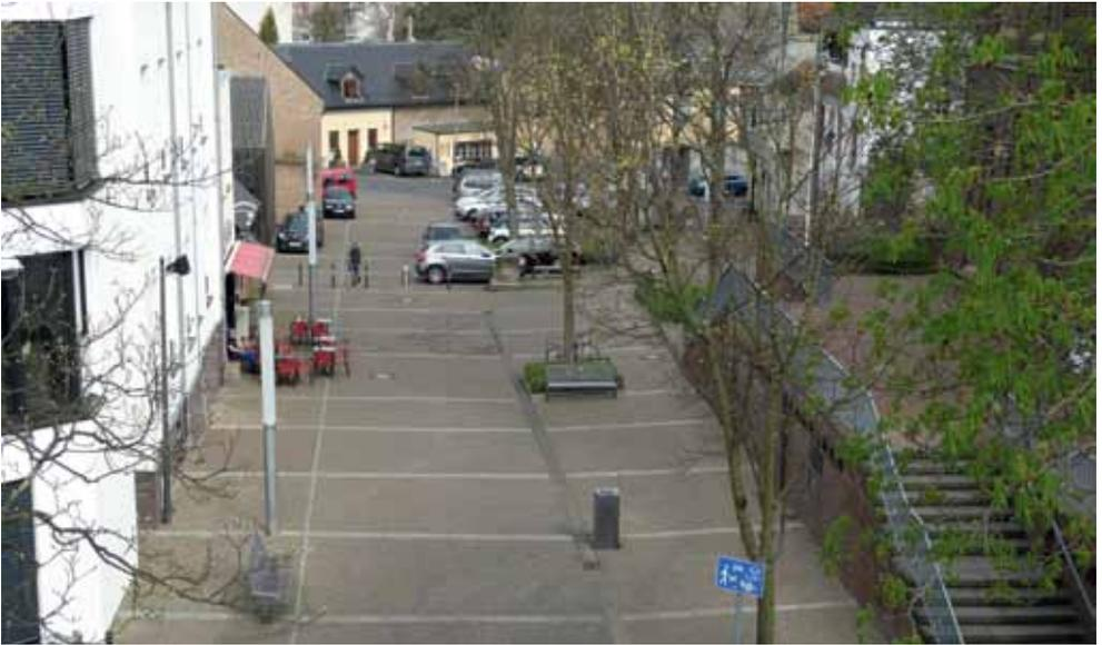
2008: Rund 1500 Quadratmeter hochwertiger holländischer Ziegel wurden in Fischgrätmuster hochkant verlegt, gerastert durch Streifen aus hellerem Betonstein.
