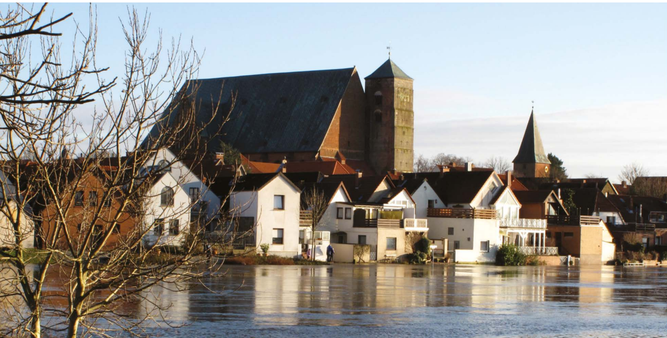
Abbildung 12: Technische Schutzanlagen bieten keinen vollkommenen Schutz: Hochwasser in Verden an der Aller - Niedersachsen (Quelle: neurolle-Rolf/pixelio.de)
