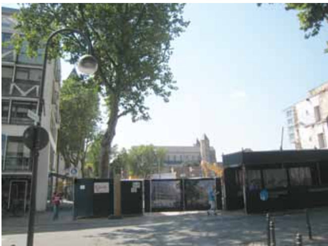
Abb. 27: Foto der aktuellen Situation am Gürzenichquartier mit Blick auf St. Maria im Kapitol
