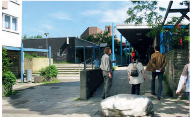
Terrassenvorbau vor Entfernung und nördlicher Teil der Fußgängerzone
