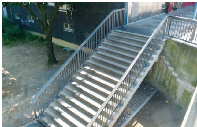
Neue Treppenanlage an der Theodor-Heuss-Straße zur Erschließung der Fußgängerzone
