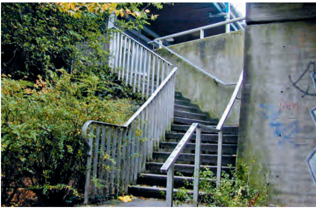
Treppenanlage Theodor-Heuss-Straße zur Fußgängerzone
