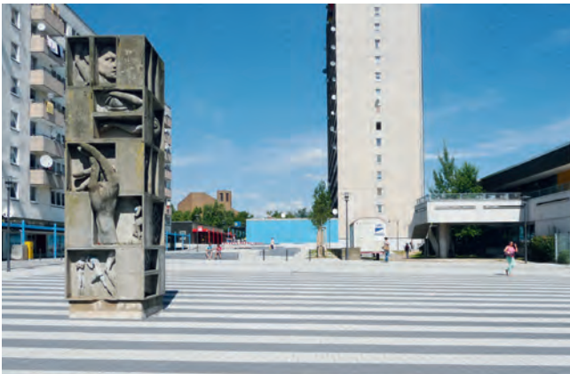
Nach dem Umbau: Zentraler Platz mit Brunnenstele mit Blick in nördliche Richtung
