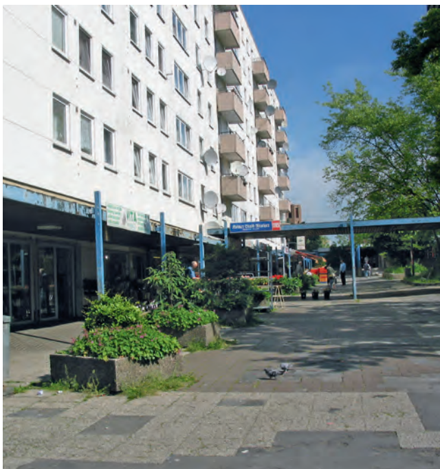
Vor dem Umbau: Blick in nördlicher Richtung zur Theodor-Heuss-Straße
