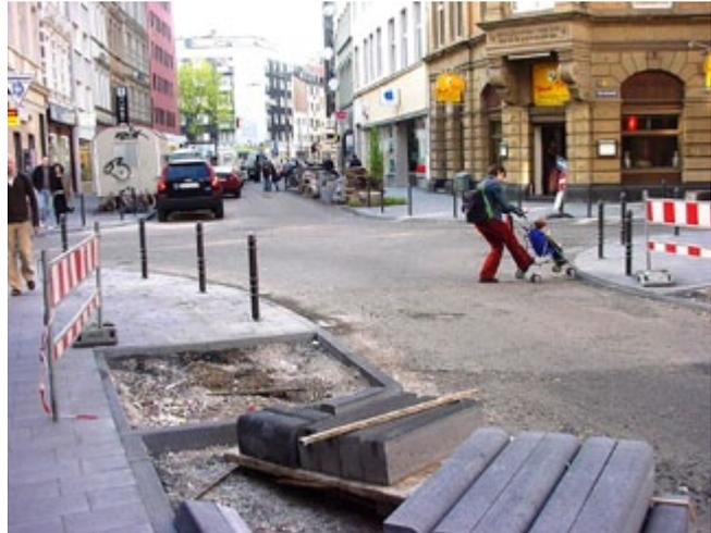
*Umbau der Weidengasse im Bereich Kreuzung Gereonswall: Verbreiterung der Gehwege in den Einmündungsbereichen und Anlage von Baumbeeten.*
