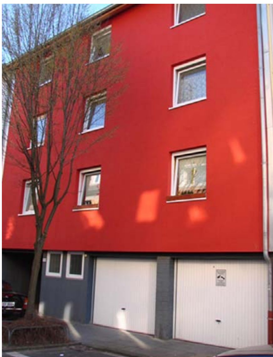
Der Zugang zum Blockinnenbereich wurde erhalten und die Baulücke geschlossen
