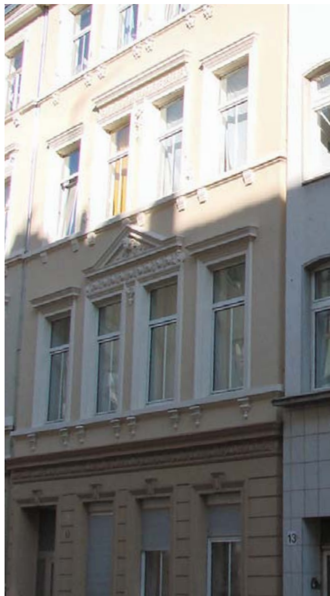
Beispiele von aufwändigen und bezuschussten Fassadensanierungen
