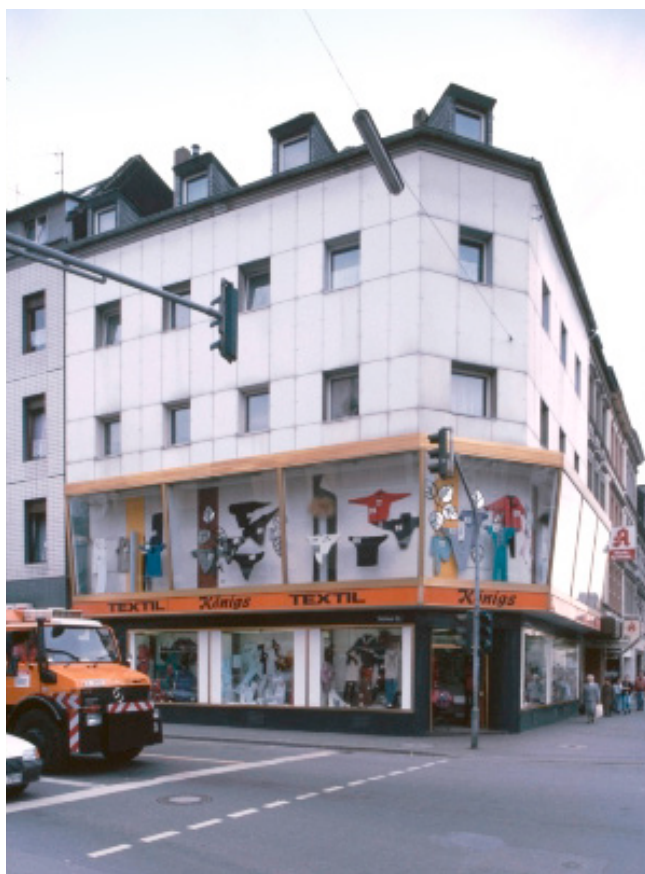
Das ehemalige Kalker Textilhaus (Ostansicht)
