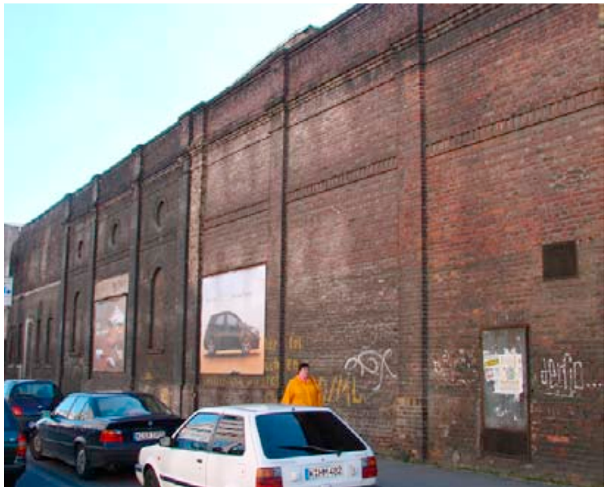
Das ehemalige Stahlhandelsunternehmen
