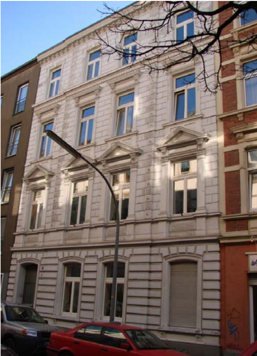
Eine aufwändige Fassadenrenovierung
