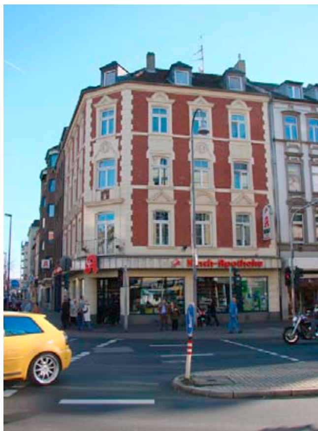
Das Haus nach Umbau und Restaurierung der Fassade (Nordansicht)
