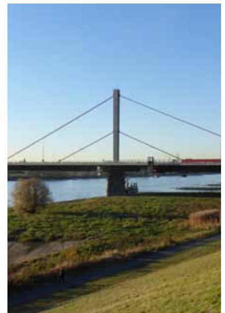
Die marode Leverkusener Brücke soll durch einen Neubau mit zwölf Autospuren ersetzt werden.
