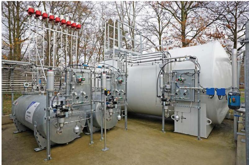
**Abb. 69:** 25 m<sup>3</sup> Tank (im Hintergrund) und die beiden 2 m<sup>3</sup> Tanks auf der WHG-Fläche.
