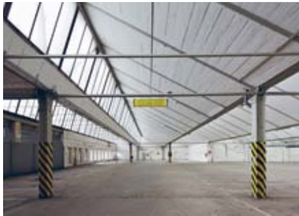
Abb. 65: Innenansicht der Shedhalle Foto: Stefan Bayer © Urbane Nachbarschaft Samtweberei gGmbH
