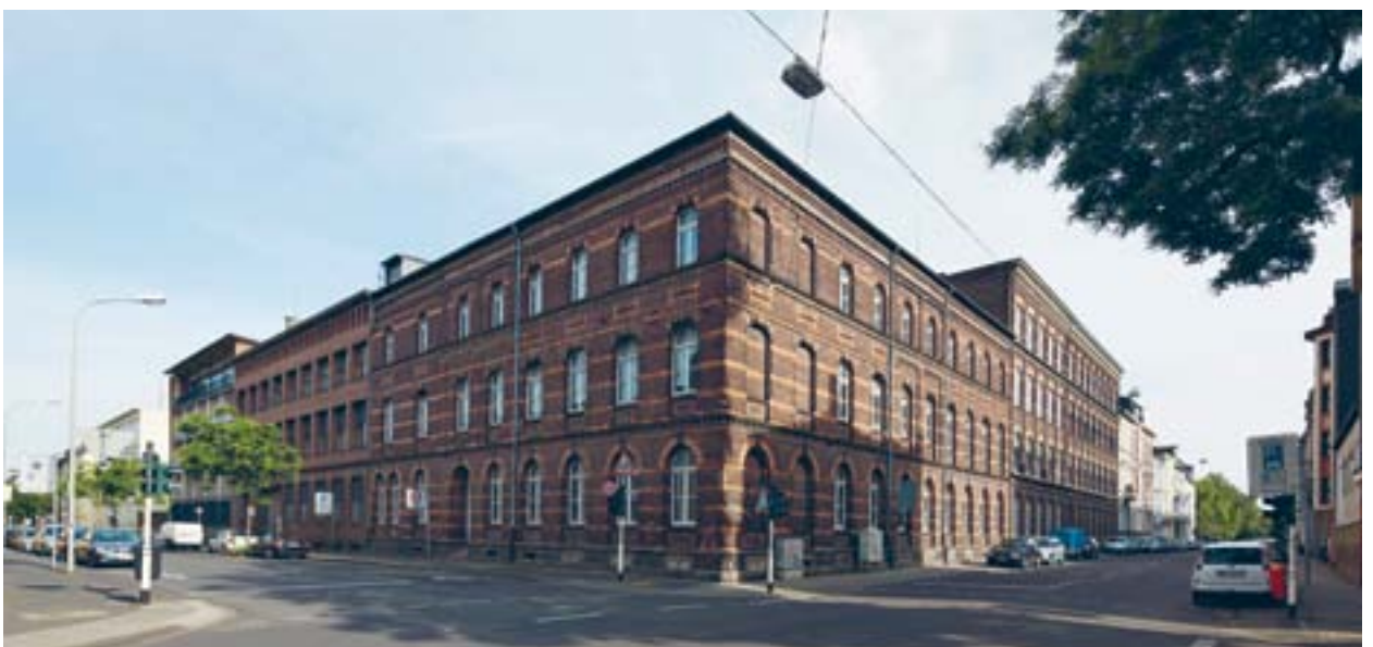
Abb. 38-45: Samtweberei im Viertel Fotos: Stefan Bayer © Urbane Nachbarschaft Samtweberei gGmbH
