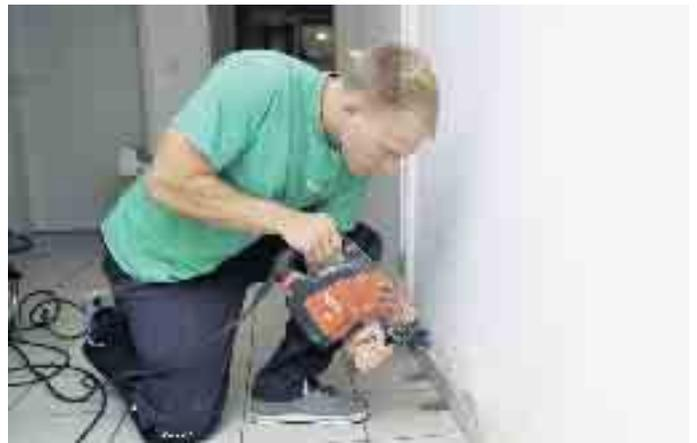
teHans & SchimmelPeter nutzen ein hydrophobierendes Injektionsverfahren, das sich seit über 45 Jahren bestens bewährt hat. Raimund Sieben erklärt: „Wir garantieren eine bauphysikalisch korrekte, dauerhafte Austrocknung. Das Mauerwerk erhält seine natürliche Fähigkeit zur Wärmedämmung zurück.“ Das Verfahren funktioniert sogar bei besonders starker Durchfeuchtung ohne Vortrocknung und wird mit einem langlebigen und gesundheitlich
