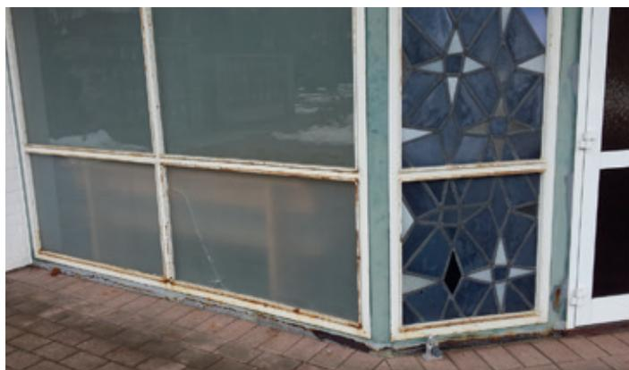
Stark korrodierte Fensterrahmen an der Leichenhalle Gemünd
