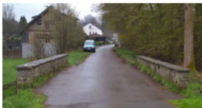
von Grund auf erneuert. Das Bauwerk führt den Verkehr der Ortsverbindungsstraße zwischen Holpe und Rolshagen über den Holpener Bach am Ortsausgang von Oberholpe. Die Brückenprüfung aus dem Jahr 2009 hat ergeben, dass das Bauwerk erhebliche Schäden im Bereich der Stahlbetonbauteile aufweist und ohne Instandsetzung dauerhaft nicht mehr den Verkehrslasten standhalten wird. Um eine zukünftige Sperrung der Straße zu vermeiden investiert die Gemeinde für die Instandsetzung jetzt rund 233.000 Euro.
