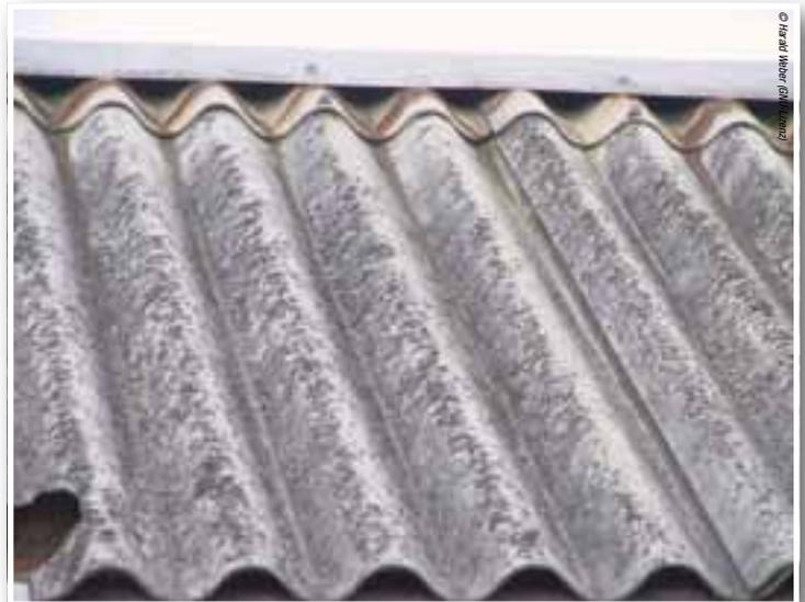
*Oft ohne ausreichenden Schutz bearbeitet: Wellplatten-Dach aus Asbest-Werkstoff.*
