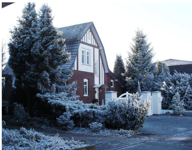
Im Jahre 1908 wurde hier der Schacht gegraben und das Pumpenhaus gebaut. Bild: GVS-Archiv
