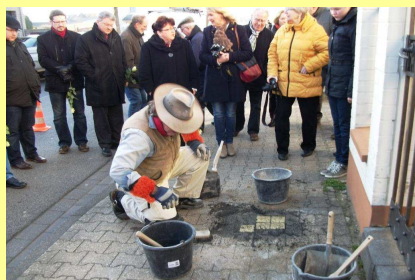
Verlegung der Stolpersteine 03.02.2014
