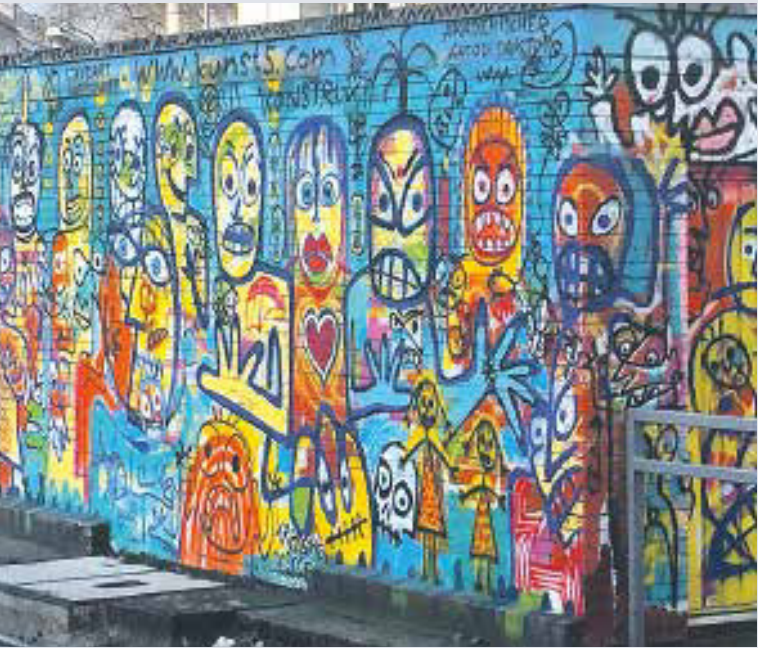
Fast schon ein Wimmelbild: das Unterwerk auf dem Barbarossaplatz
