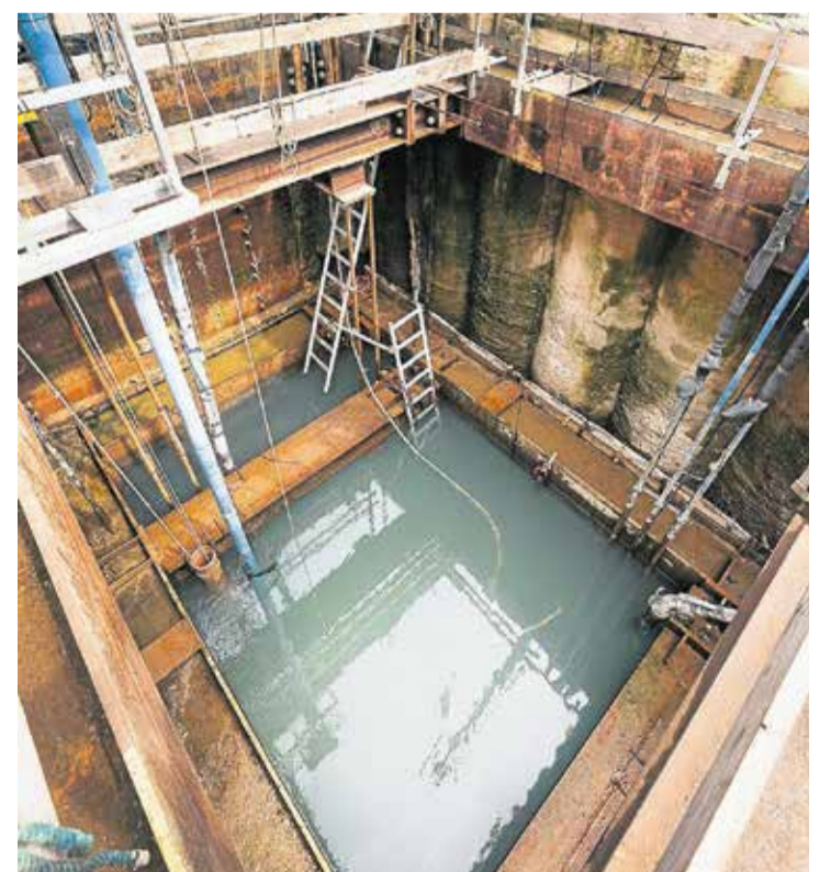
Blick in die Besichtigungsbaugrube am Waidmarkt
