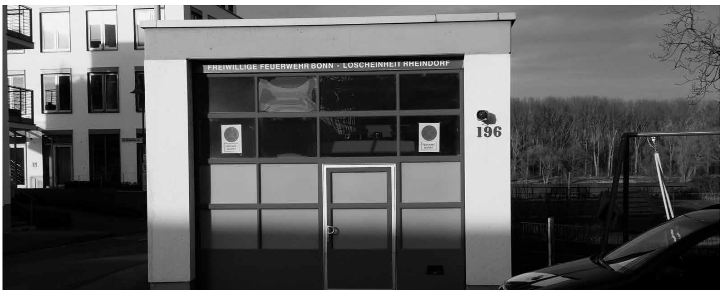
Durch das zu nah parkende Auto an der Fahrzeughalle der Löscheinheit Rheindorf müsste das Löschfahrzeug mehrmals rangieren um die Kurve fahren zu können. Wertvolle Zeit geht verloren!
