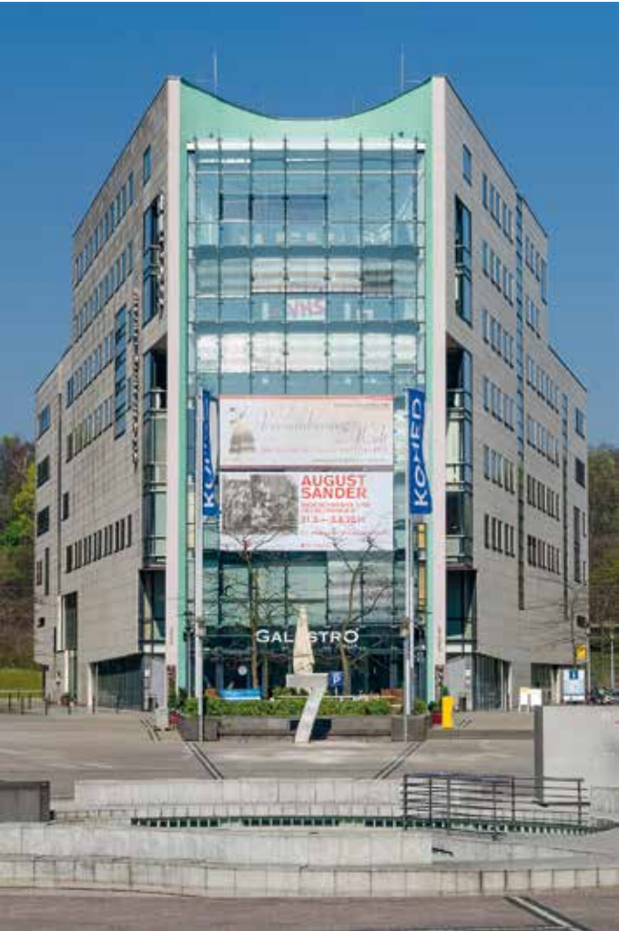
Gebäude MP7 | Foto: Niklas Rausch
