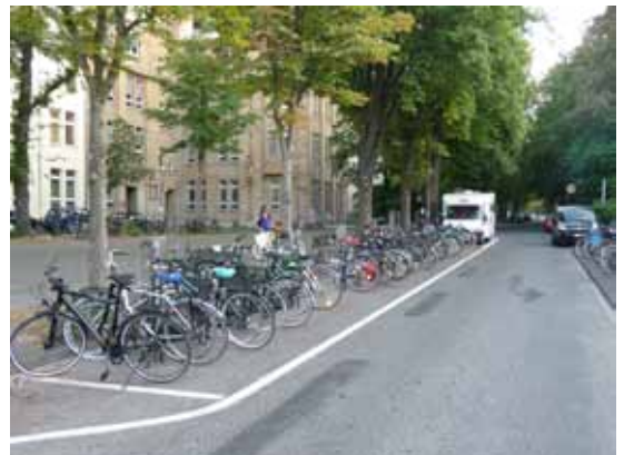
Neue Fahrradabstellanlage am Westbahnhof: Am Venloer Wall wurde eine überflüssige Rechtsabbiegespur beseitigt, um Parkfläche für bis zu 60 Fahrräder zu schaffen.
