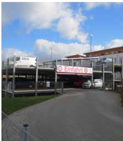
Parkhaus am Siedlungsrand
