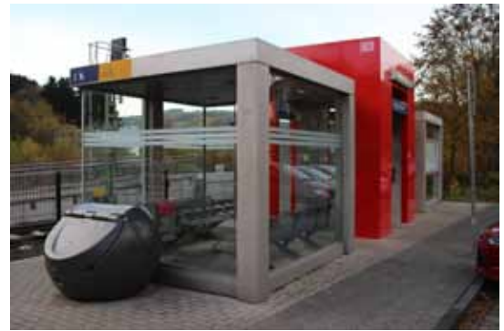
Am Bahnhof Engelskirchen hat die DB einen Fahrgastunterstand mit Serviceeinrichtungen und einen barrierefreien Zugang gebaut. [Foto: F. Bihn]
