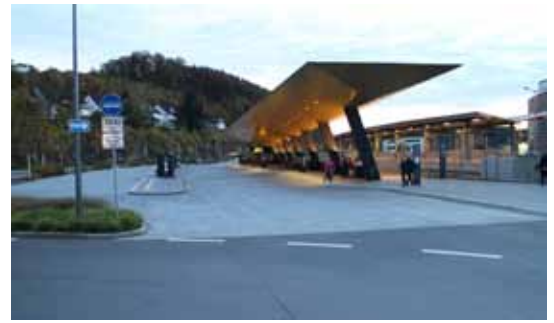
Bei der Neugestaltung des Gummersbacher Zentrums wurden ein neuer Bahnhof (rechts) und ein Busbahnhof (links) gebaut. [Foto: F. Bihn]
