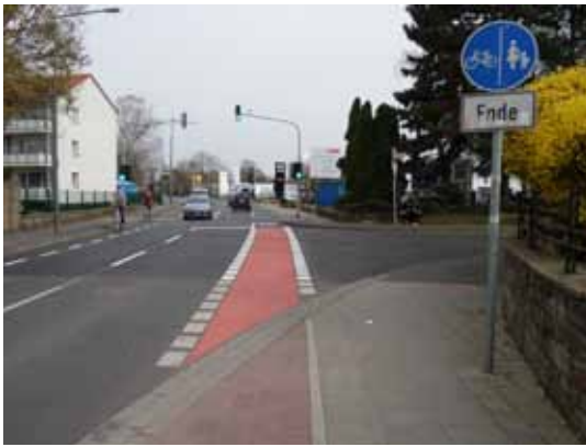
Neue Schutzmarkierungen an der Kaiserstraße in Köln-Porz
