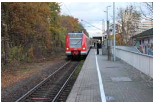
Der Bahnhof Duckterath soll ein zweites Gleis erhalten. [Foto: F. Bihn]
