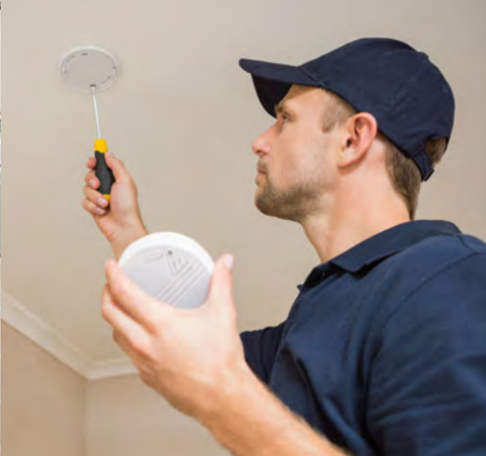
Für die Planung, Ausführung und Kontrolle ganzheitlicher Brandschutzkonzepte, stehen ausgewiesene Fachleute zur Verfügung.
