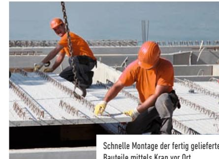
Schnelle Montage der fertig gelieferten Bauteile mittels Kran vor Ort.
