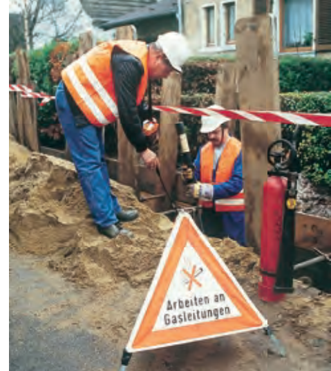
Mit dem Beginn des Erdgaszeitalters stieg die Nachfrage und damit die Neuverlegung von Erdgasleitungen.
