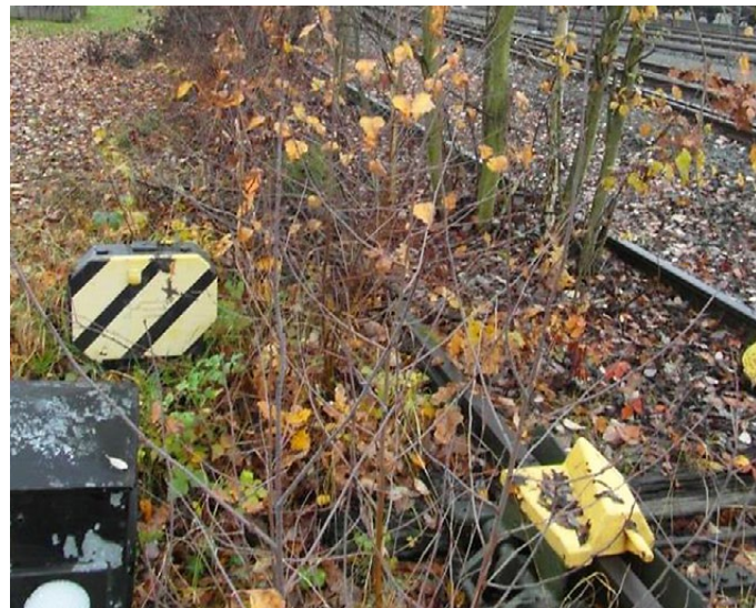
Abbildung 38.1 Junge Bäume im Schotteroberbau des abzweigenden Stranges einer Weiche Quelle: Bundesrechnungshof.
