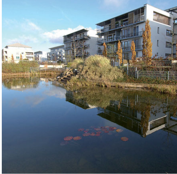
EXPO-Siedlung Regenrückhaltebecken. Foto: Helmut Lemke
