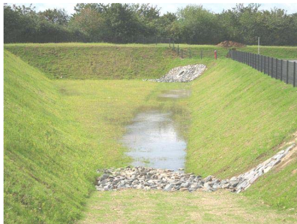
Versickerungsbecken eines Baumarktes
