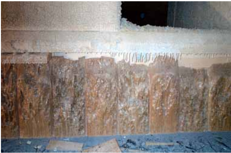
Bild 4: ZrO_2 -Palisadensteine in einer Bildschirmglaswanne.
