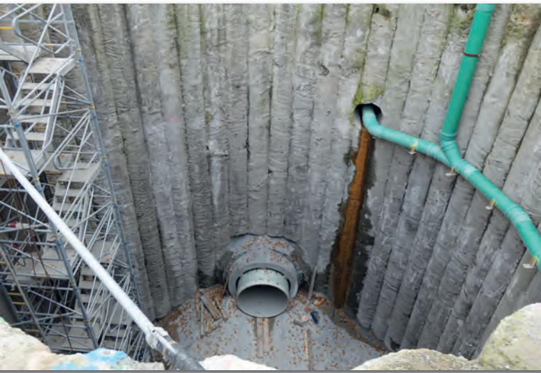
Bild 2: Über die mit Bohrpfehlen gesicherte Baugrube erfolgten die Vortriebsarbeiten und der Einzug der Flowtite GFK-Profile.
