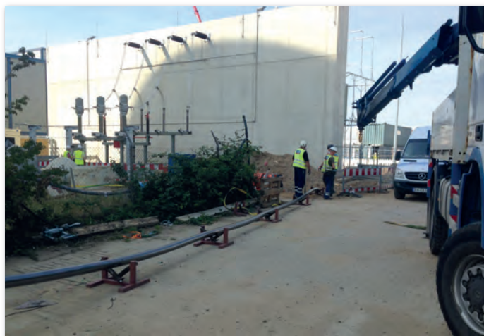
Bild 7: Einzug Erdkabel auf dem Kraftwerksgelände
