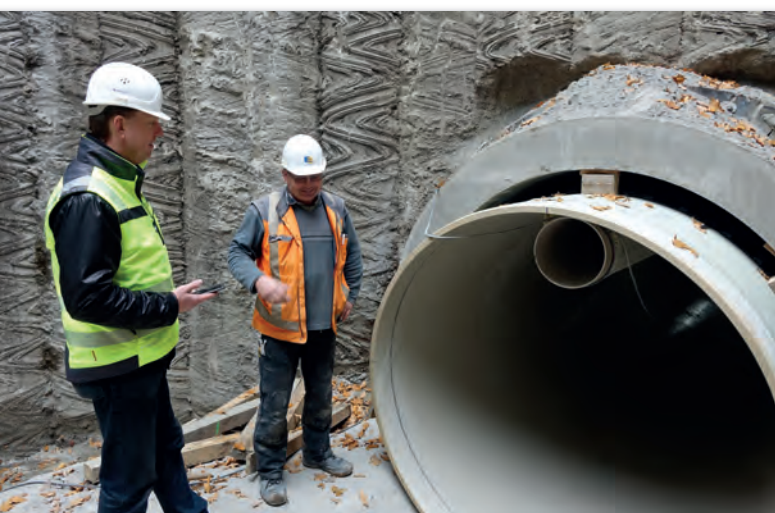
Bild 4: Polier Hermann Schürmann (re.) und Amiantit Gebietsleiter Thomas Wede bei der Besichtigung der fertigen Haltung. Mit Abstandshaltern wurden die Flowtite GFK-Profile in den Mantelrohren fixiert.
