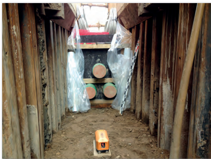
Bild 6: SHV-Schutzrohre für 380 kV Erdkabel im Leitungsgaben
