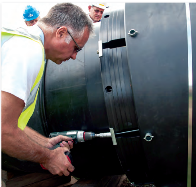
Bild 4: Aktivierung der Schweiß-Keilringe
