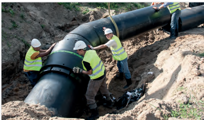
Bild 2: Einbindung des Passstücks in die Rohrleitung
