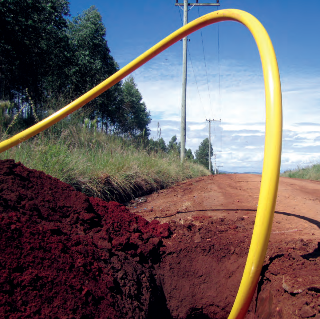
Bild 2: Auch grabenlose Verlegung ist mit Gasrohren aus VESTAMID® NRG möglich.
