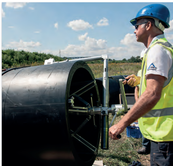
Bild 5: Großrohrschälgerät FWSG XL
