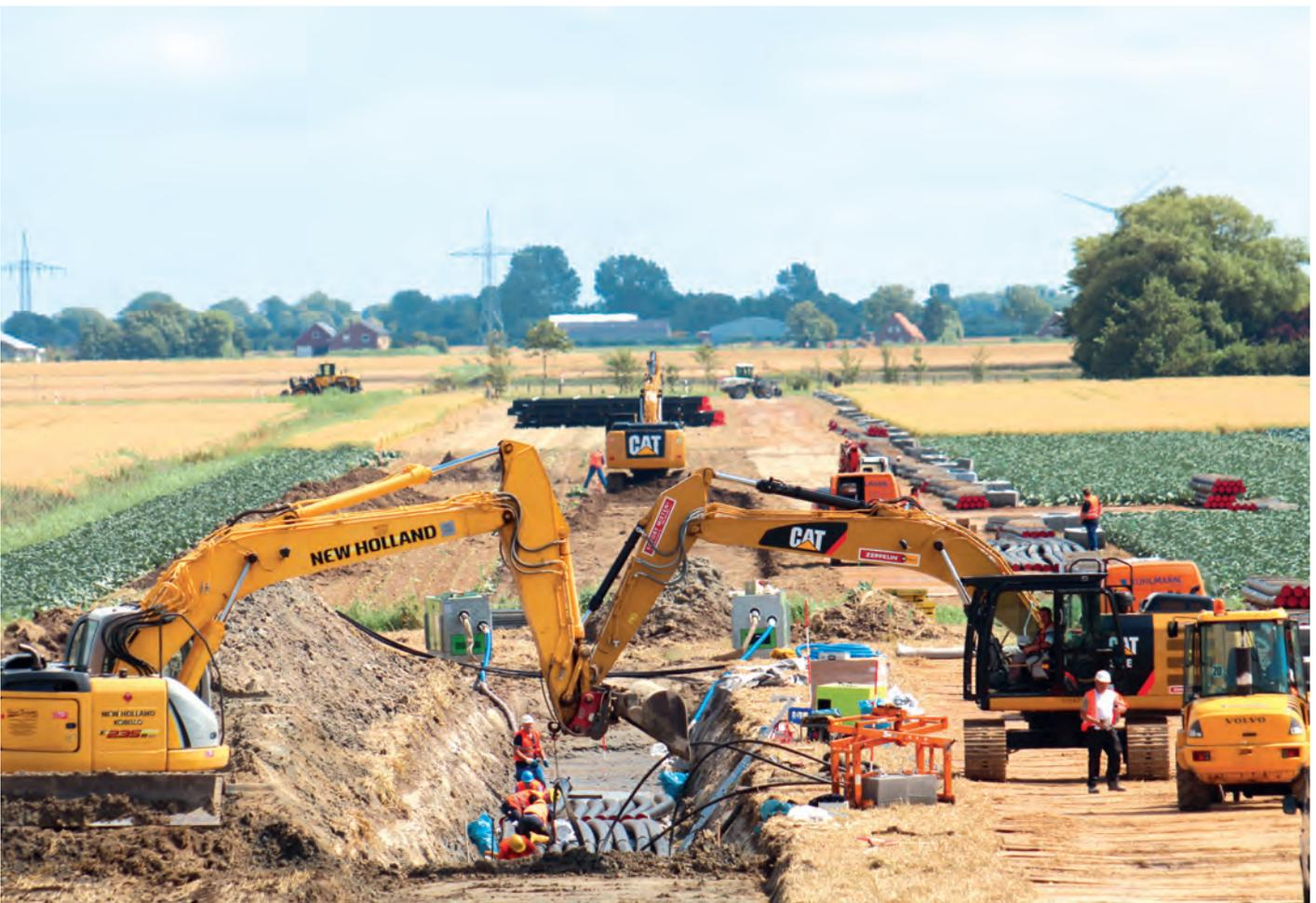
Bild 3: Kabelschutzrohre in der Verlegung
