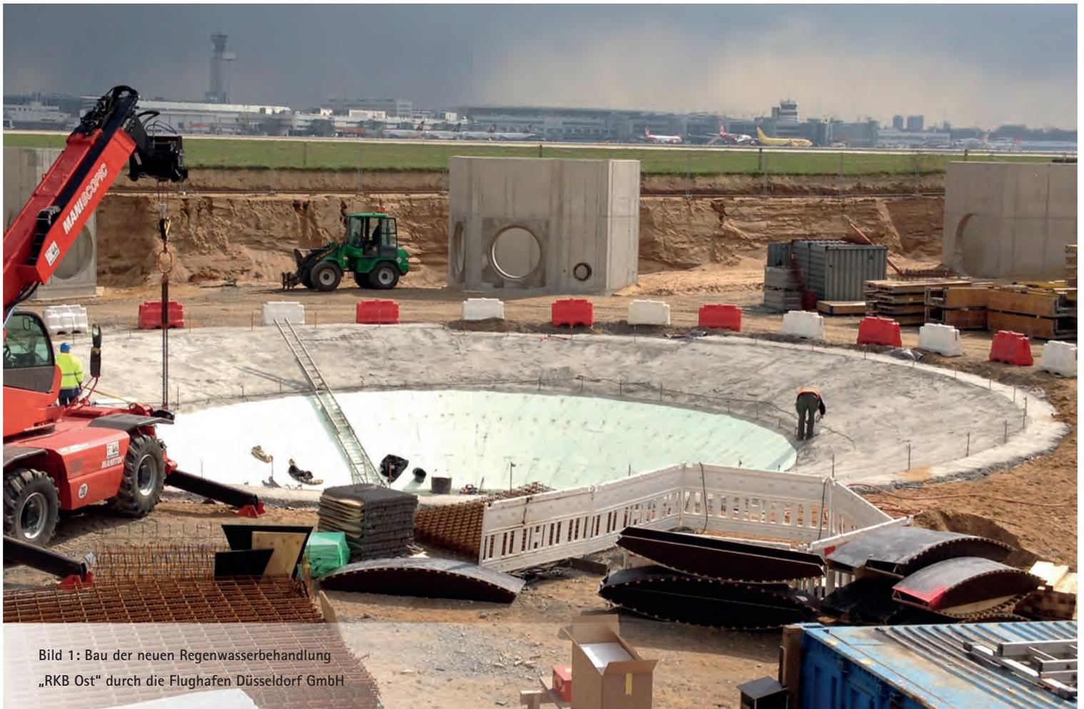
Bild 1: Bau der neuen Regenwasserbehandlung „RKB Ost“ durch die Flughafen Düsseldorf GmbH
