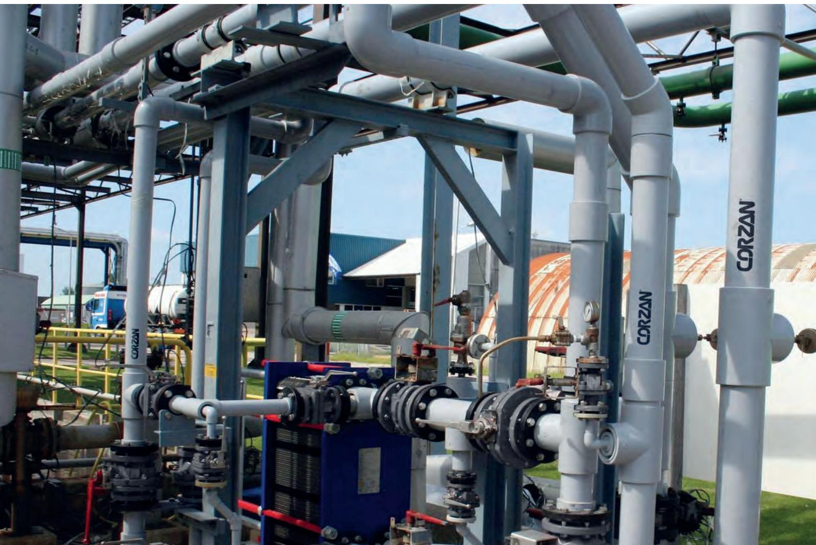
Seit dem Einbau hat das Rohrleitungssystem aus PVC-C bewiesen, dass es die Dauerhaftigkeit und Korrosionsresistenz besitzt, die notwendig ist, um in der rauen Produktionsumgebung zu bestehen. Seit der Erstinstallation wurde es daher zum Rohrmaterial der Wahl bei zahlreichen Modifizierungen und Erweiterungen in der Fabrik, zuletzt Ende 2014. Solche Erweiterungen wurden notwendig, um die bestehende jährliche Kapazität mehr als zu verdoppeln.
