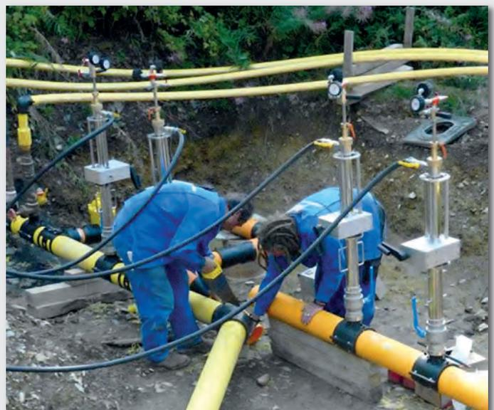
Trinkwassernetz und der verfahrensbedingt eingebrachten Materialbelastung in der Quetschfalte wird das Quetschen selten eingesetzt.
