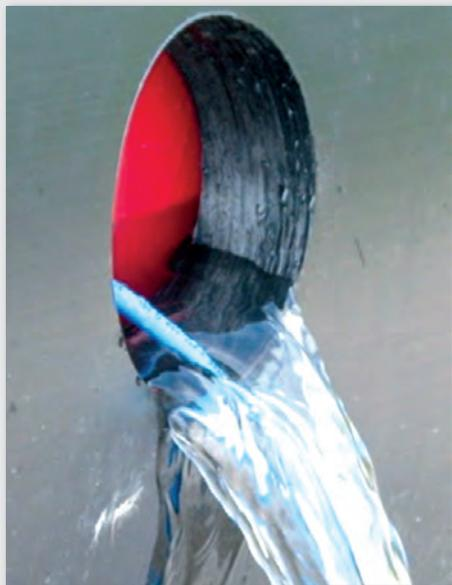
Bild 12: Ein Sattelformstück, hier ein Reparatursattel, der mit Vakuumspanntechnik montiert wird, verschließt das Anbohrloch
