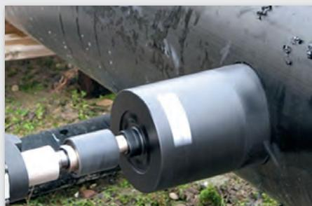
Bild 9: Einbringen des Reparaturballons
