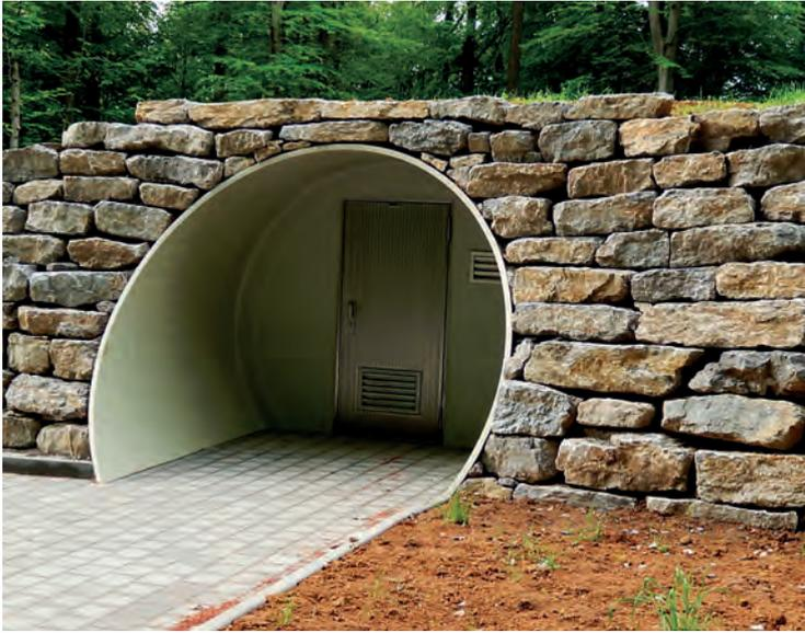
Bild 2: Der Zugang zur Schieberkammer wird mit einer Sicherheitstür aus Edelstahl der Widerstandsklasse WK3 gesichert. Foto: ASG
