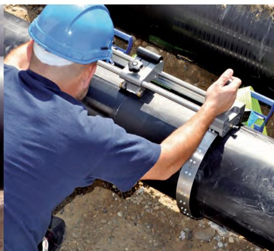
Bild 3: Schweißnahtvorbereitung – Schälen der Schweißfläche
