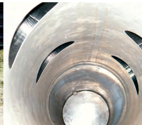
Bild 3: Blick in das Kanallinnere: Glatte, versatzfreie Einläufe; helle Innenschicht unterstützt die TV-Inspektion
