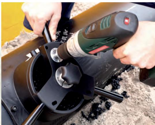
Bild 4: Anbohrvorgang mit FWFIT
