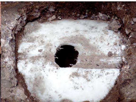
Bild 8: Freigelegtes Compact Pipe nach dem Auffräsen
