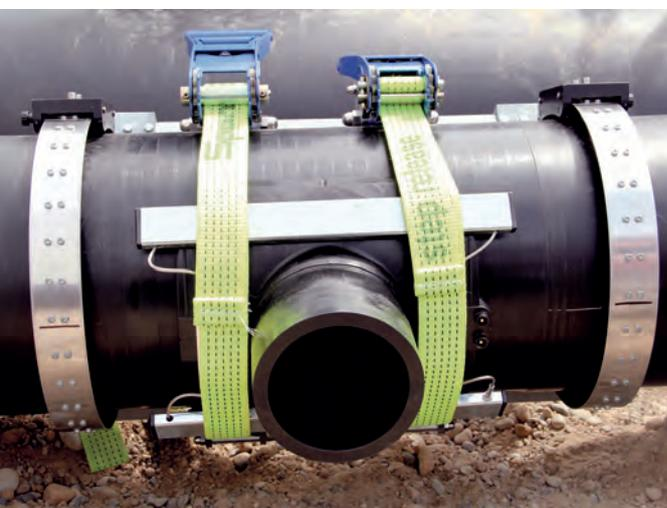
Bild 2: Installation ELGEF Plus-Anschlusssattel im Rohrgraben
