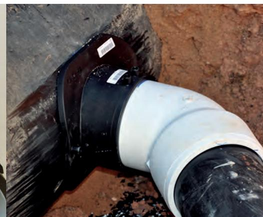
Bild 6: Anbohrvorgang mit FWFIT
