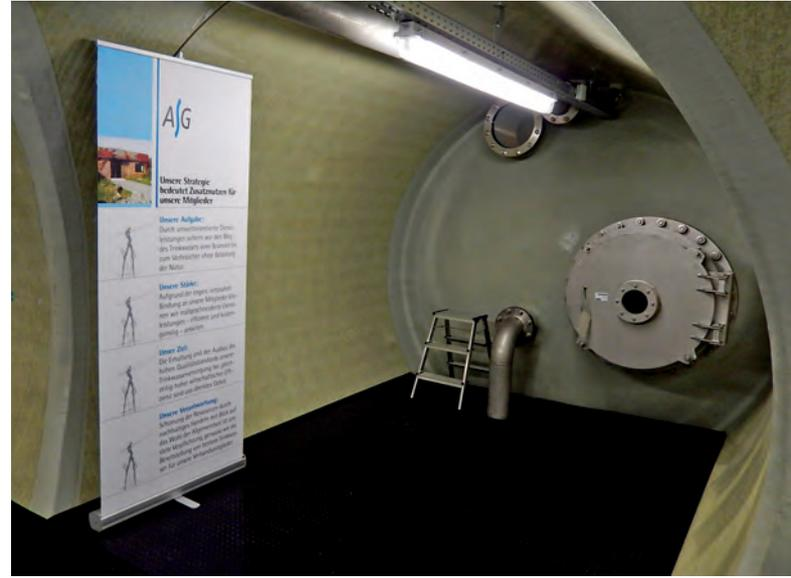
Bild 3: In die Stirnseite der Trinkwasserbehälter wurde zu Wartungszwecken eine Drucktür DN 800 aus Edelstahl eingebaut. In der linken oberen Ecke des Behälterabschlusses sind zusätzlich noch Sichtluken DN 300 eingebaut, die eine visuelle Kontrolle des Behälterinnenraumes ermöglichen. Die Zulauf- und Entnahmeleitungen liegen unterhalb des betretbaren Gitterrostes. Foto: ASG
