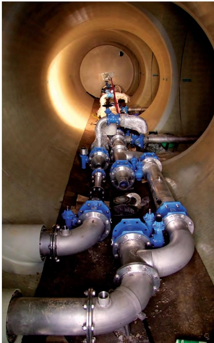
Bild 4: Montage der Zulauf- und Entnahmeleitungen sowie der notwendigen Absperr-Armaturen in der Schieberkammer. Foto: ASG
