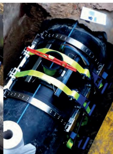
Bild 4: PE 100-Rohr Relining mit ELGEF Plus-Anschlusssattel für Rohrentlüftung
