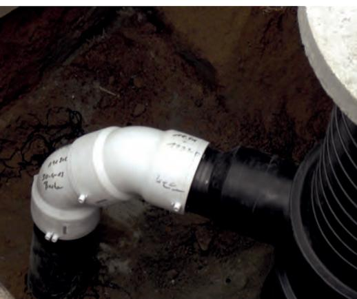
Bild 1: Materialhomogener Anschluss eines Straßeneinlaufes
