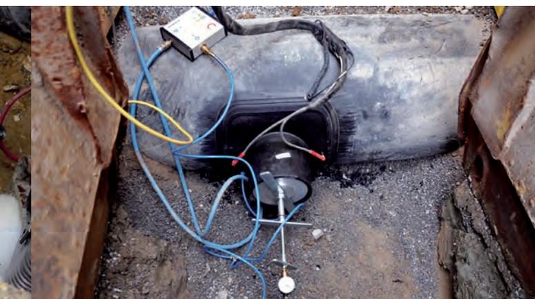
Bild 10: Mit VACUSET XL aufgespannter Abwassersattel ASA-VL
