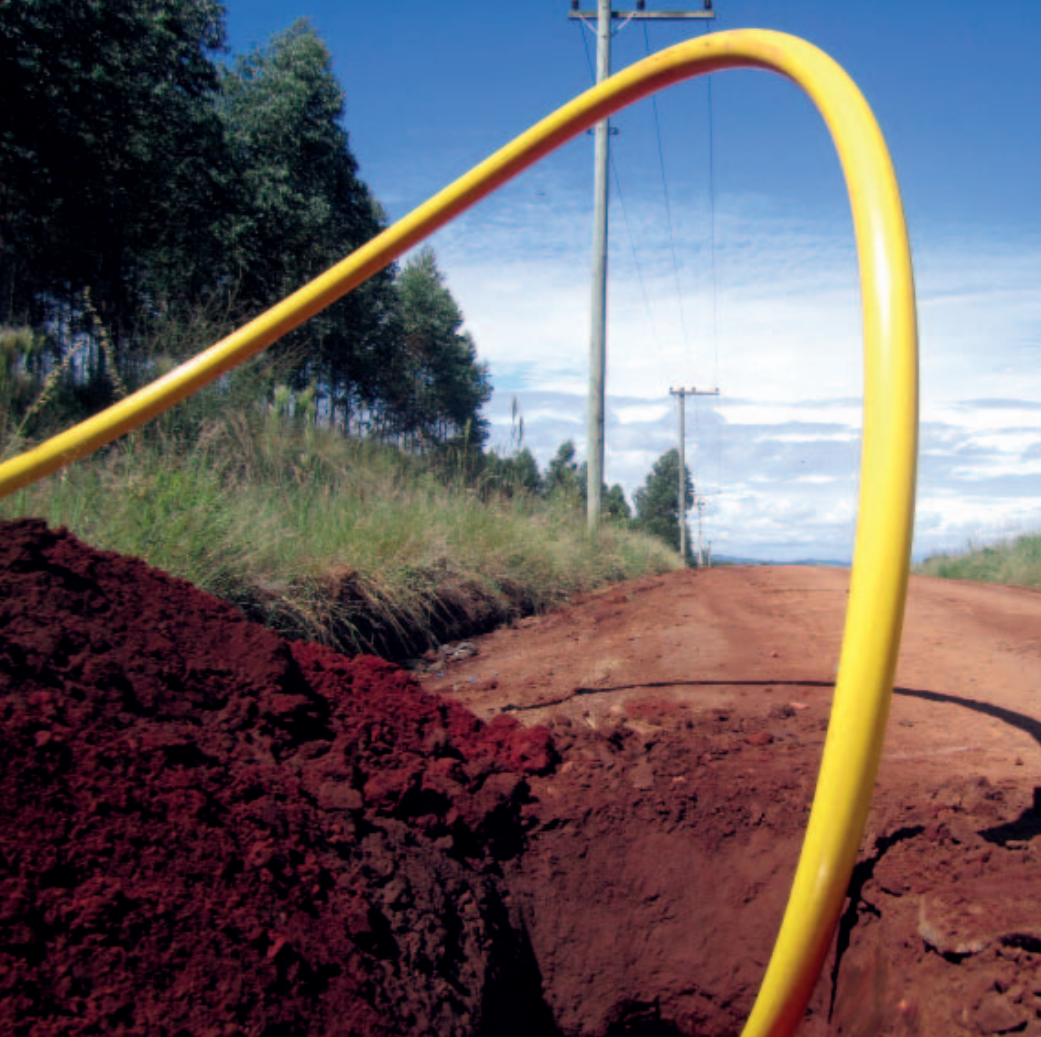
Auch grabenlose Verlegung ist mit Gasrohren aus VESTAMID® NRG möglich.
