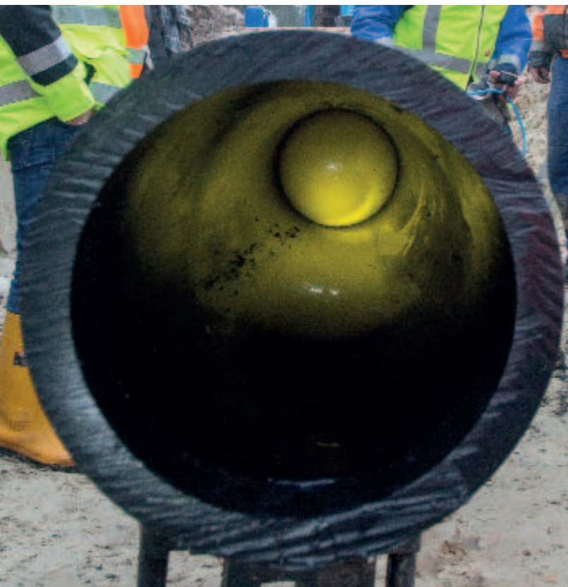
Der Reparaturballon dichtet im Rohr gegen nachfließendes Wasser ab
