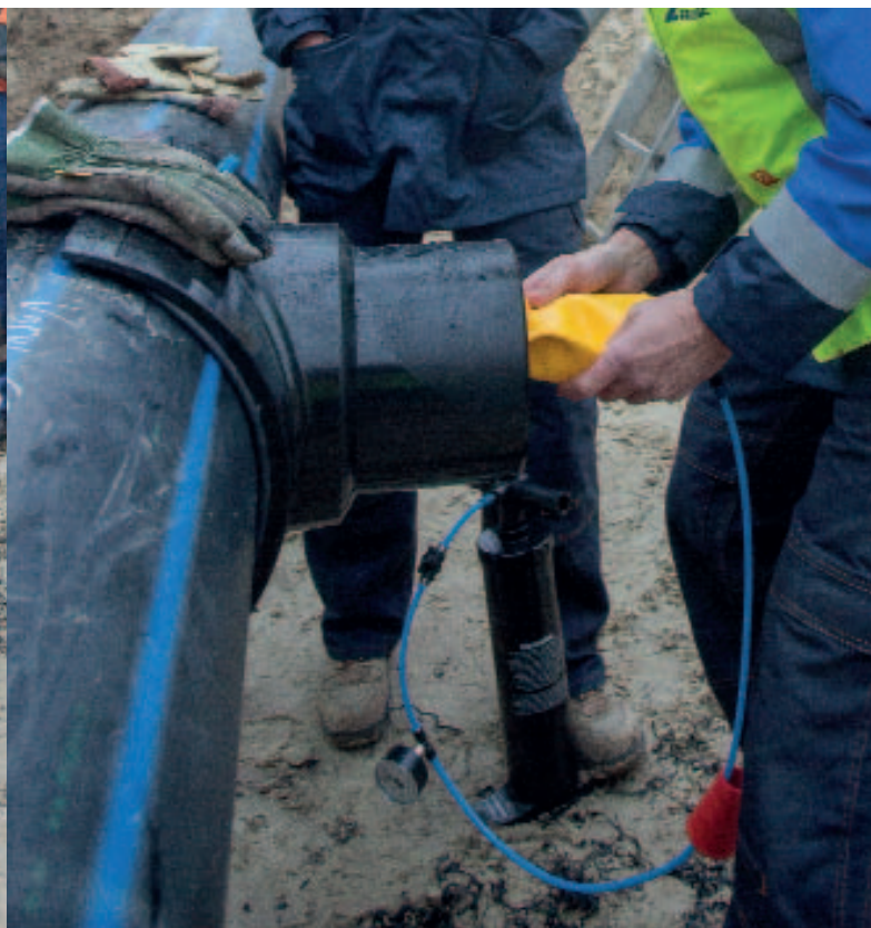
Einbringen des Reparaturballons
