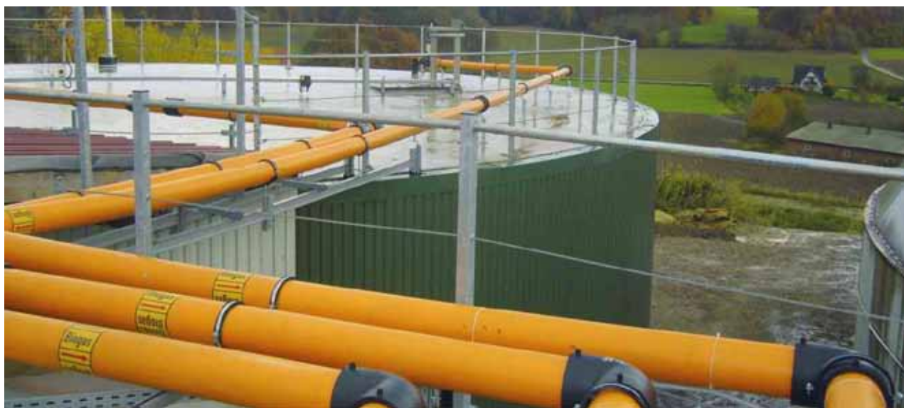
Rohrleitungsbau in Biogasanlage (Quelle: Georg Fischer)
