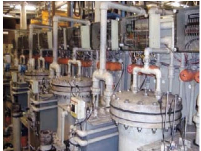
Bei dem Rückgewinnungsprozess von Säurebeize (Salpetersäure 20 % und Flußsäure 5 %) zur Oberflächenbehandlung von Metallen gewährleisten Rohrsysteme aus PP-H einen störungsfreien Betrieb.
