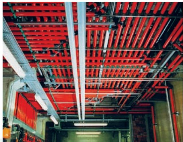
*Einsatz von Lebensmittel-zugelassenen PVC-Rohrsystemen in der Essig- und Konservenindustrie (hier: 25 % Eisessig bei  $T = 15\text{degC}$ )*
