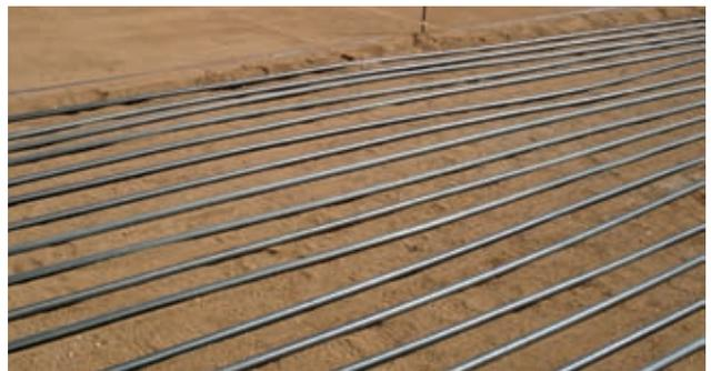
Eis und Schneefreihaltung von Straßen, Brücken, Park- und Lagerplätzen. In Kombination mit der Kühlung von Produktionswässern entsteht eine hocheffiziente, ressourcenschonende Kälteanlage bestehend aus einem Kunststoffrohrwärmetauschersystem.
