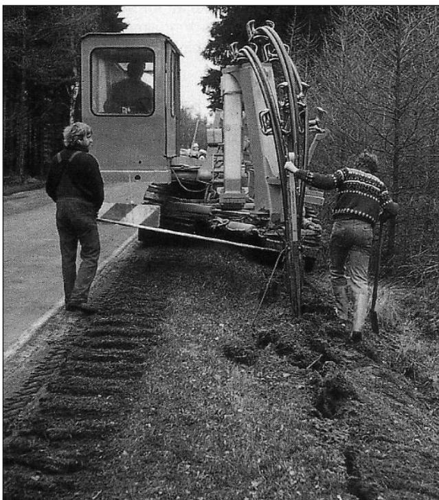
Einpflügen von Kabelschutzrohren aus PE-HD
