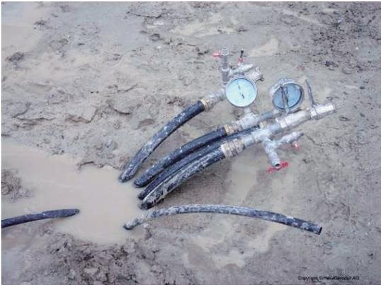
**Abbildung 9: Hinterfüllte Erdwärmesonde mit Manometer zur Druckkontrolle [24]**
