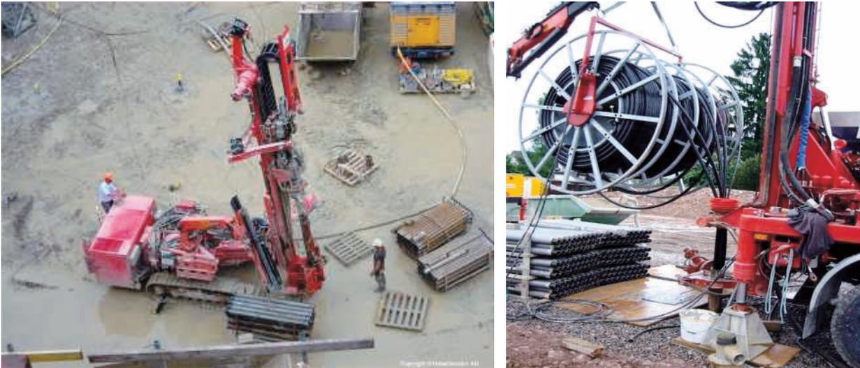
Abbildung 3: Bohrung [24] und Abteufen der Erdwärmesonde [25]
