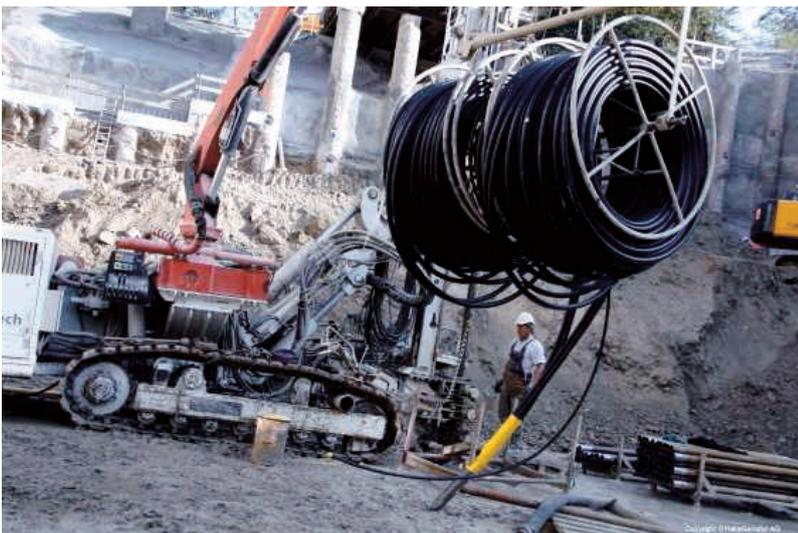
**Abbildung 4: Haspel zum schonenden Einbau der Erdwärmesonde [25]**
