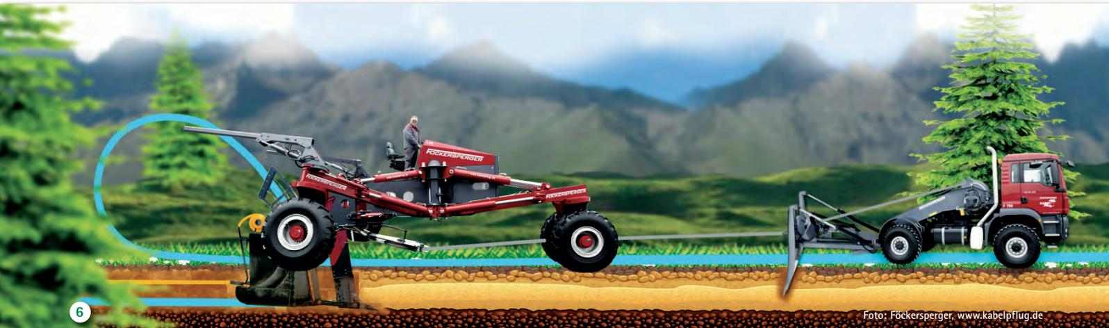
schließlich wird das Neurohr in das Bohrloch eingeschoben oder eingezogen. Das Verfahren eignet sich für die Sanierung, wenn ein neuer Kanal verlegt werden soll, der die Funktion des vorhandenen, geschädigten Kanals übernimmt. Beim Pilotbohrverfahren sind Längen bis 120 m und Durchmesser bis 1.200 mm möglich.
