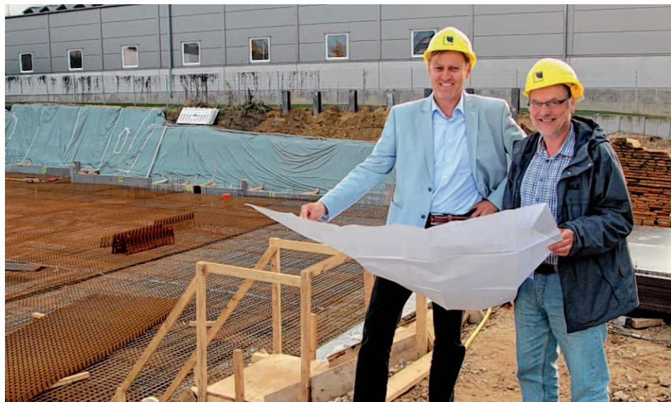
Edwin Büchter (l.) und Dr. Winfried Barkhausen (beide geschäftsführender Gesellschafter) begutachten die Fortschritte auf der Baustelle. Fotos: Myriam Weber
