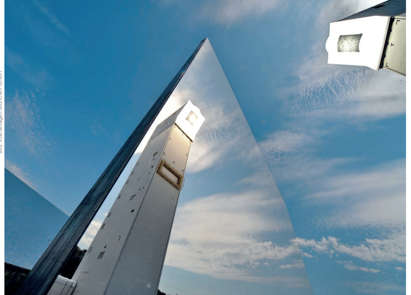
Das solarthermische Versuchskraftwerk Jülich bei Köln dient den Wissenschaftlern zum Test neuer Komponenten und Verfahren, die Solarkraftwerke effizienter und kostengünstiger machen
